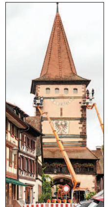
Das Foto vom Oktober 2019 zeigt, wie Spanngurte am Obertorturm angelegt wurden. Diese sichern das Gemäuer. Archivfoto: Th. Reizel
